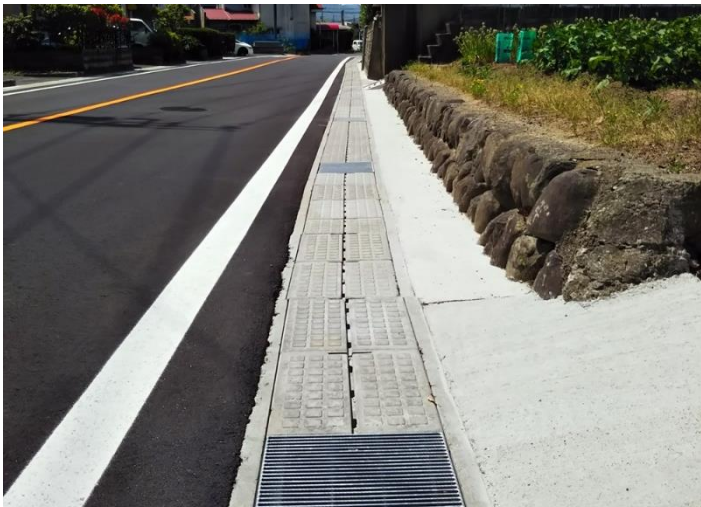
【B300】 鳥取市/市道東今在家橋線道路改良工事(交付金)
